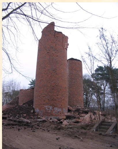
Abbruch Turmtropfkörper
