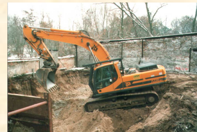
Erdarbeiten ALF 5C
